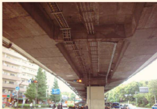
炭素繊維シート施工前
