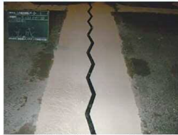
補修後(伸縮装置の取替え)
