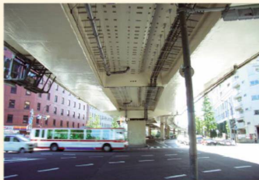
炭素繊維シート施工後
