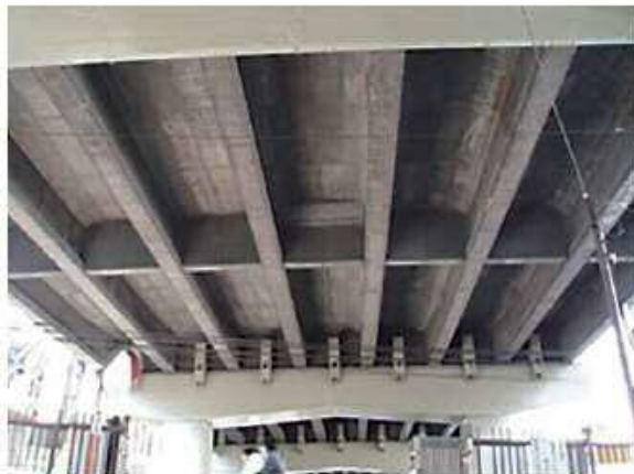
補修前(コンクリートのひび割れ)
