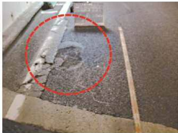
補修前(舗装の穴)
