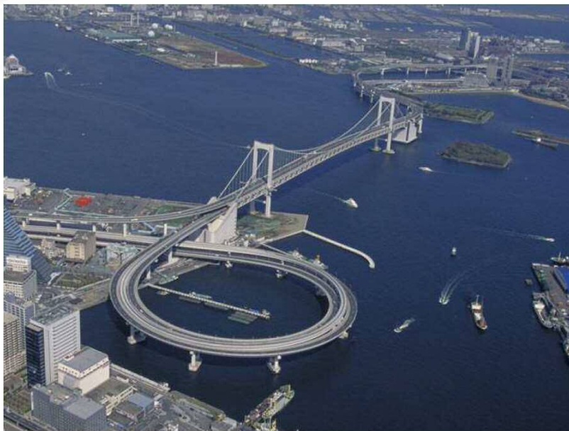
レインボーブリッジ 橋長: 798m 中央支間: 570m 平成4年8月供用開始
