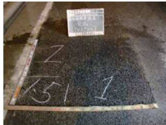
補修後(舗装の部分打ち換え)
