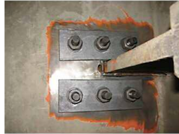
補修後(当て板補強)
