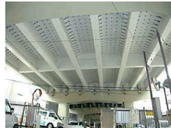
補修後(シート繊維補強)
