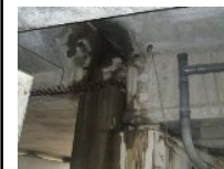
凍結防止剤による塩害劣化状況
