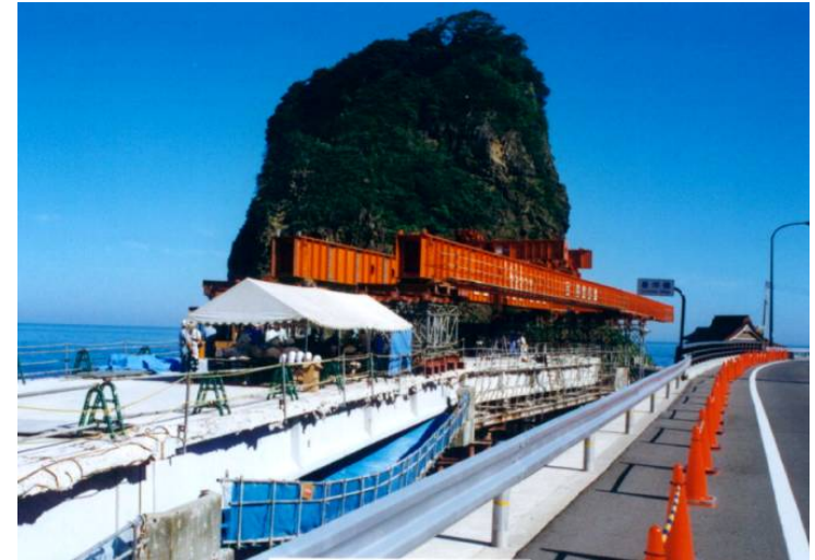
塩害の例 暮坪橋 左:旧橋 右:新橋
