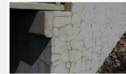
補強鋼板の浮き
