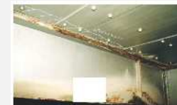
補強鋼板の浮き
