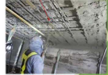
断面修復材吹付状況
