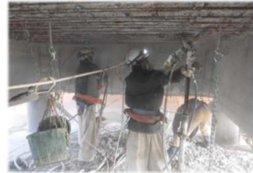
スラブ下面研り状況
