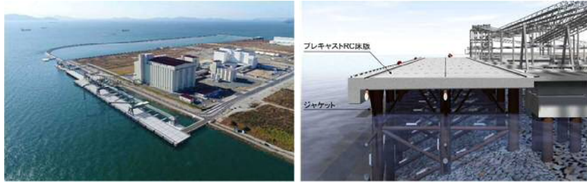
プレキャストRC床版を用いた栈橋の完成イメージ [出典: 中国地方整備局宇野港湾事務所]
