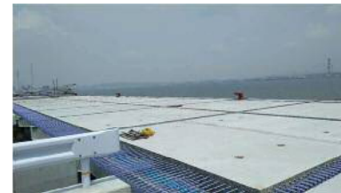
RC床版据付け完了
