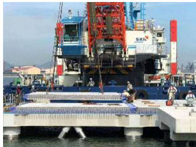
RC床版据付け状況
