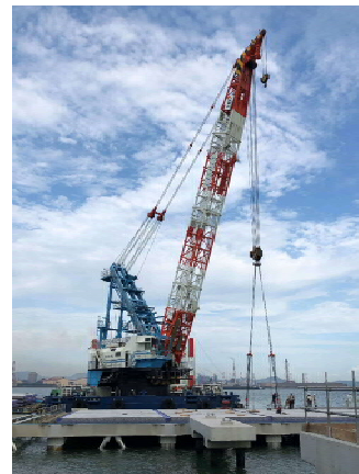
RC床版据付け状況
