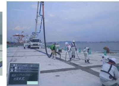
間詰コンクリート打設状況
