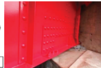
桁端部の当て板・塗装
