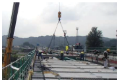
プレキャスト床版による 打ち替え
