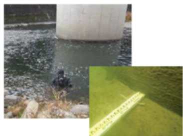
潜水調査による河床洗掘の把握
