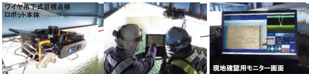
ワイヤ吊下式目視点検ロボットによる点検状況
