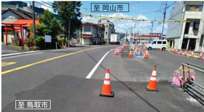
工事中区間の状況（拡幅概成。引き続き、歩道等を整備）
