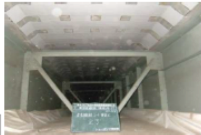
炭素繊維シートの貼り付け
