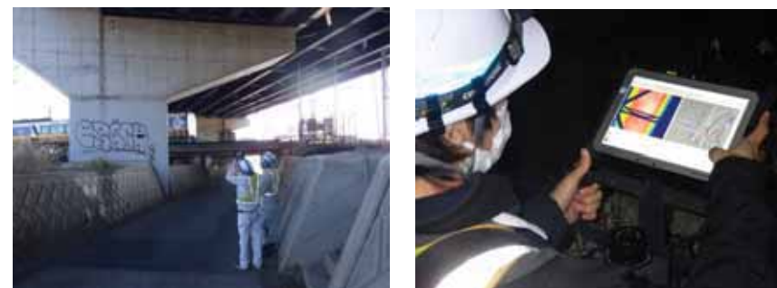
赤外線調査状況
