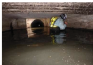
滞水した溝橋内部の目視点検
