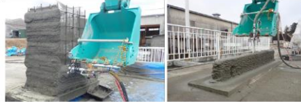
埋設型枠の造形(高さ約1.5m)
