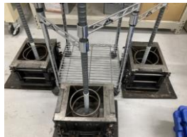
写真2-1 補修モルタル打込み前
