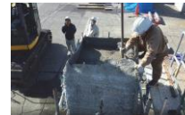
作製した埋設型枠と中詰めコンクリートの付着強度 平均2.28N/mm 2
