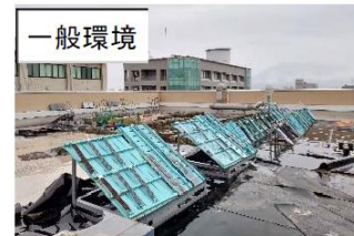
鹿児島大学 海洋土木工学 科棟屋上
