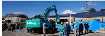
新開発のハイブリッド吹付けシステムを取付けたICT建機による直接プリント造形
