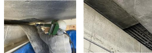
狭隘部吹付状況
