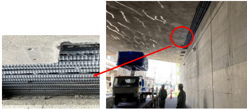
鉄筋防錆処理後
