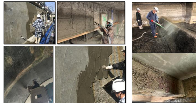
塩害等で劣化したコンクリートの修復工事
