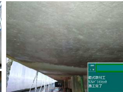
張り出し床板(歩道部)
