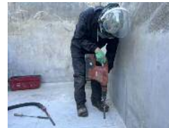
ドリル削孔状況
