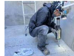
カートリッジ式樹脂注入
