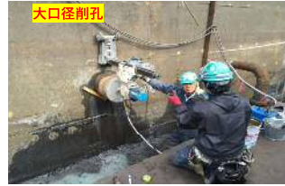
大口径削孔
