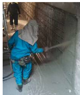
カルバート補修
