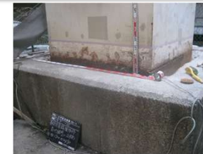
基礎ハツリ後全景
