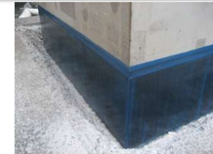
ストランドシート施工完了
