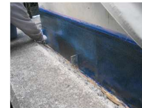
炭素繊維シート周巻き施工
