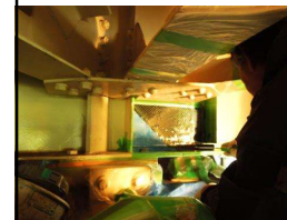
+45° 方向シート施工
