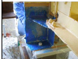
不陸修正パテ施工
