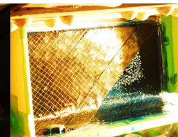
-45° 方向シート施工
