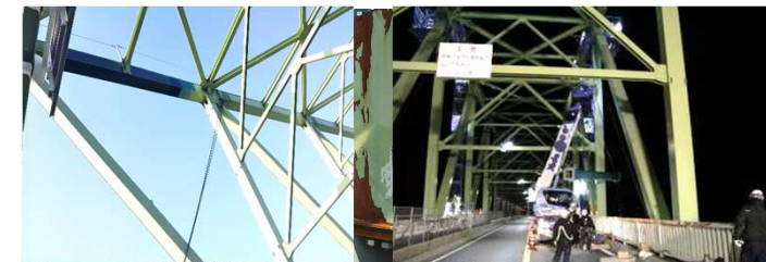
上弦材(圧縮部材)の 座屈防止の応急補強
