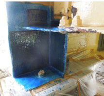
炭素繊維シート工完了
