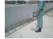
CS-2 I 散布 (打継ぎ部)
