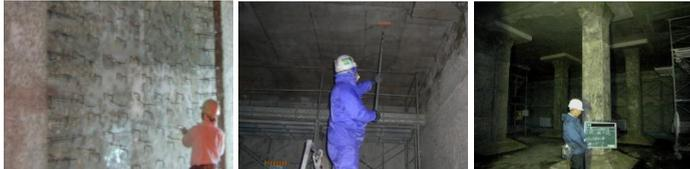
導流壁（耐震補強増厚前） CS-21塗布（天井） 施工完了
