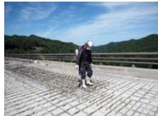
CS-2 I 散布 (打継ぎ部)
