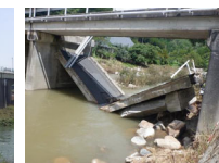
2023.8 大石大木橋 (岡山県吉井川)
