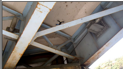
ビデオ 1：非常に狭い箇所への進入状況
