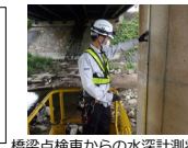
橋梁点検車からの水深計測状況
